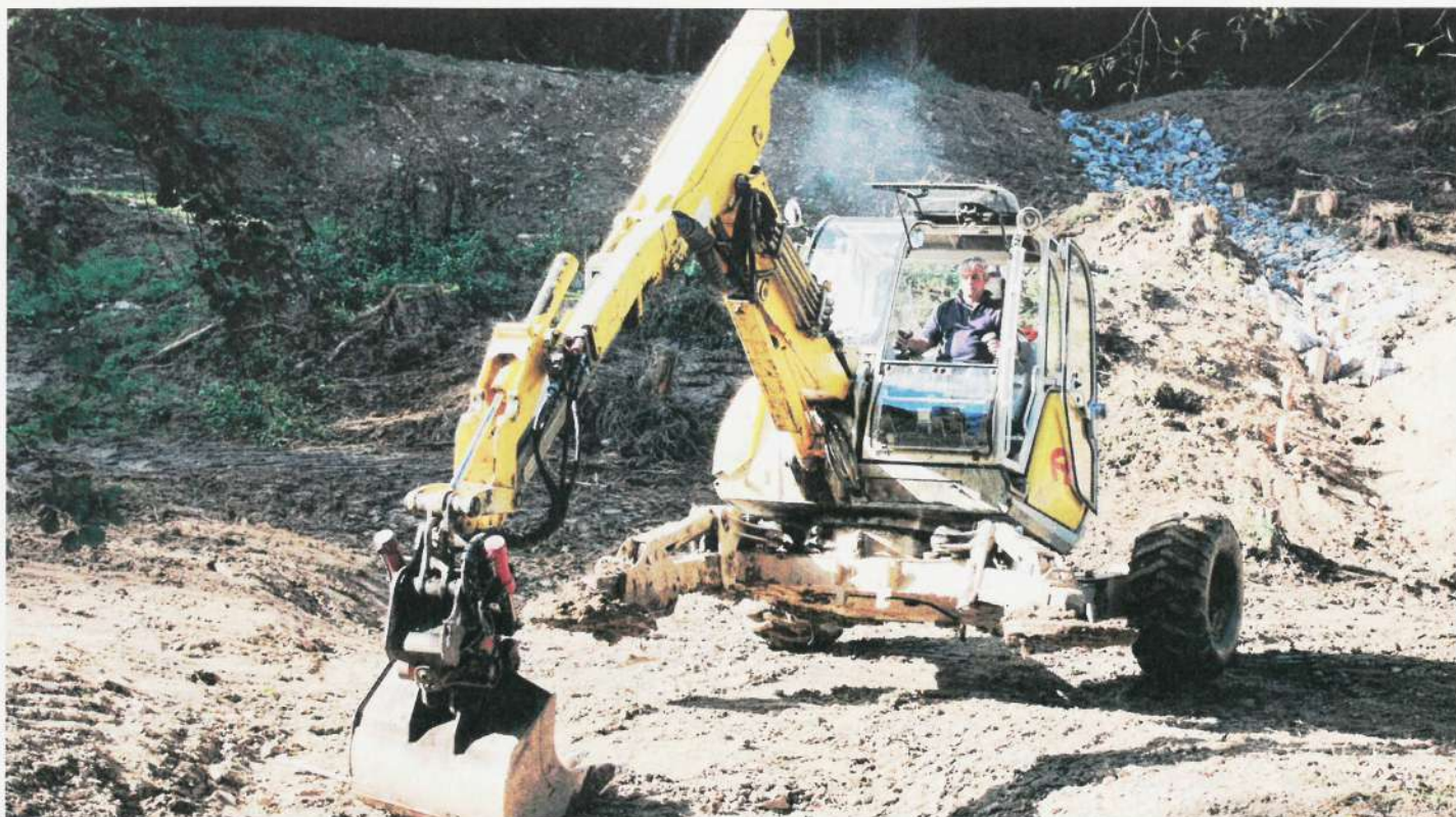
Timo Becker modelliert mit Hilfe des Schreitbaggers das Gelände, im Hintergrund ist eine Gewässerrinne zu sehen, die vorher betoniert war.
