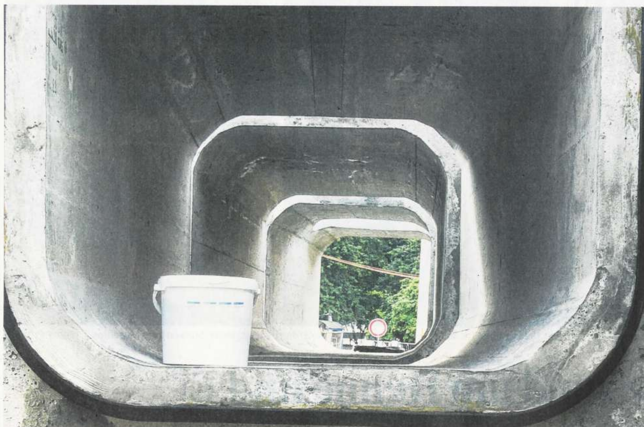
Hochwasserschutz in Bröl: Der Walbach bekommt ein großes Kastenprofil.
