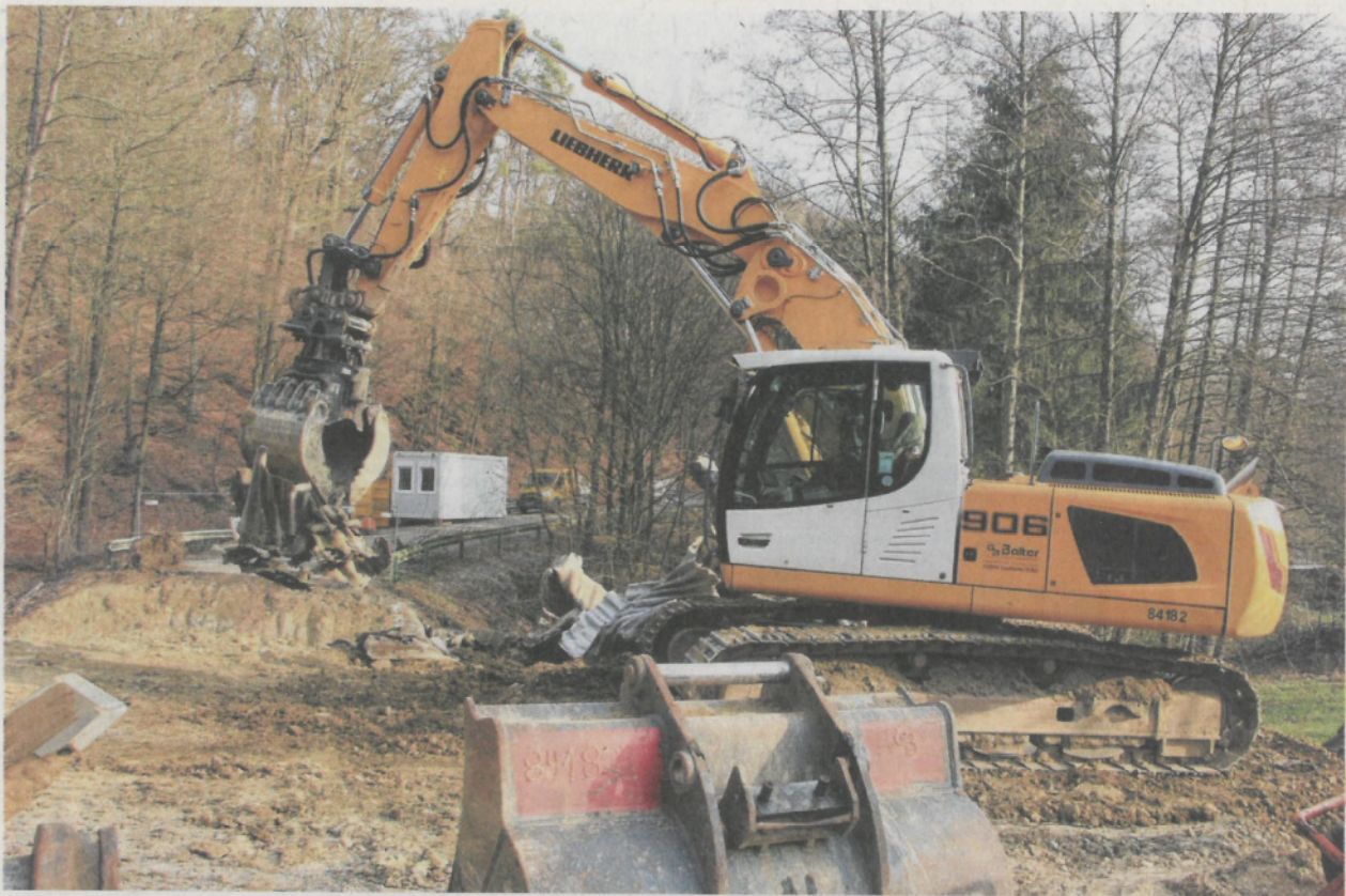
Die letzten Reste des alten Wellstahlprofils der Brückenkonstruktion werden mit dem Bagger herausgezogen.
