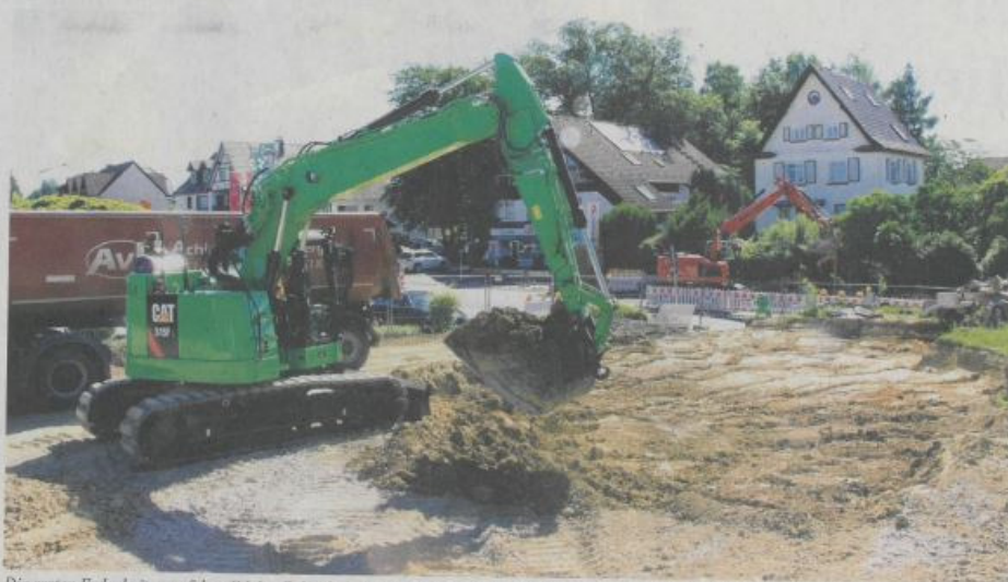
Die ersten Erdarbeiten auf dem Edeka-Gelände haben begonnen. Hinten auf der Zeithstraße steht der rote Bagger der Straßenbaufirma.
